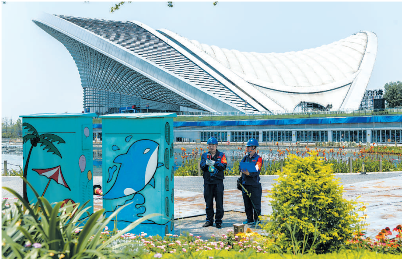
成都第31届世界大学生夏季运动会开幕在即，国家电网成都大运会电力保障团队已全面进入保电决战状态，由6400余人、318台发电车组建的510支队伍，全力以赴确保各场馆正常用电。图为近日国家电网成都供电公司大运会电力保障队员在场馆外巡视电力设备。张超摄
