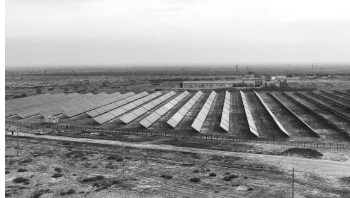
中国石油塔里木油田轮南光伏电站。塔里木油田供图
