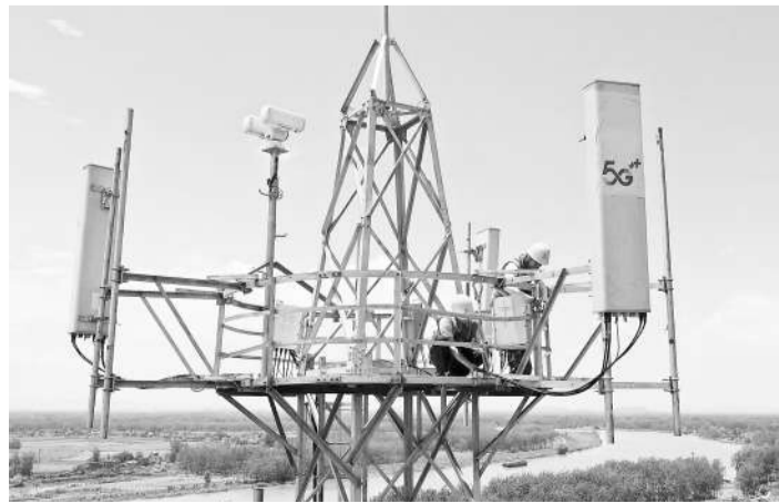
在5G基站，工作人员正在调测天线。
