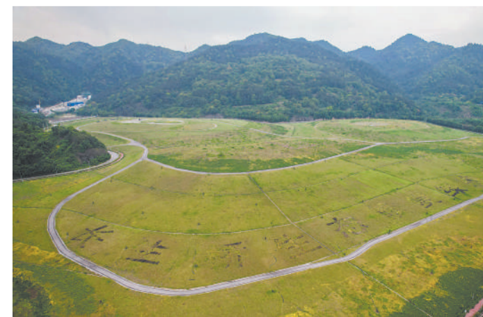
修复后的长生桥垃圾填埋场。重庆市规划和自然资源局供图
