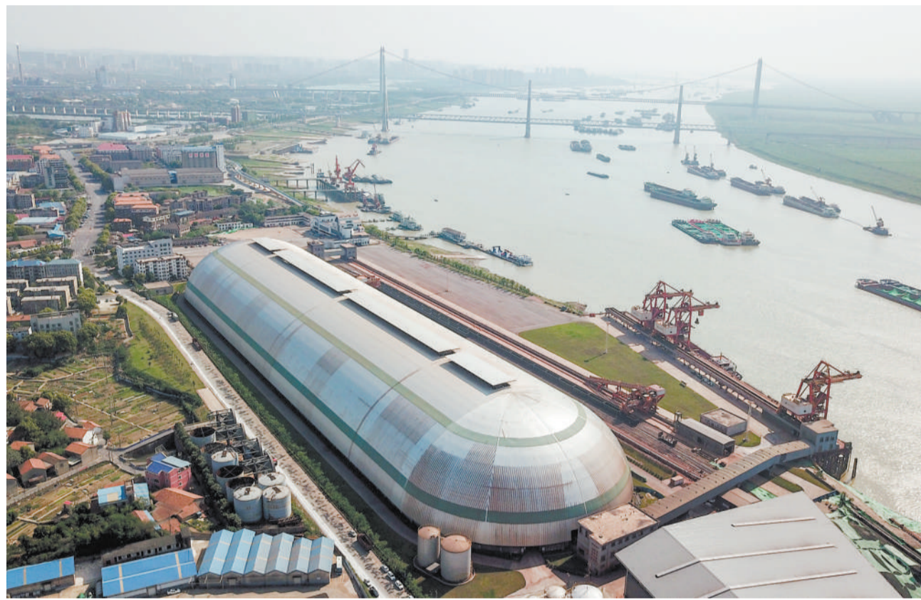
右图 4月17日拍摄的城陵矶港“胶囊”形散货大库(无人机照片)。下图在“胶囊”形散货大库内,工作人员查看除尘设备运行情况。新华社记者 陈泽国摄
