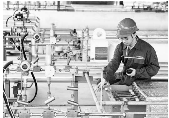
南方电网广东广州供电局氢能研究中心工作人员正在检查固态储氢装置气体进出阀门的开启情况。 甘丽莉摄
