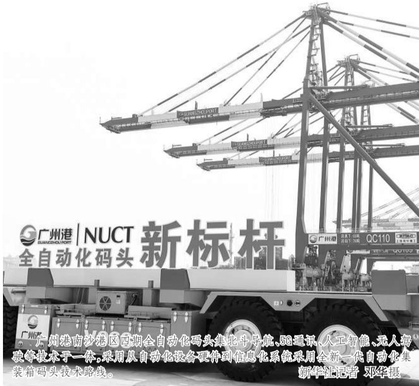
广州港南沙港区二期全自动化码头集北斗导航、5G通讯、人工智能、无人驾驶等技术于一体，采用从自动化设备硬件到信息化系统全流程新一代自动化集装箱码头技术路线。
