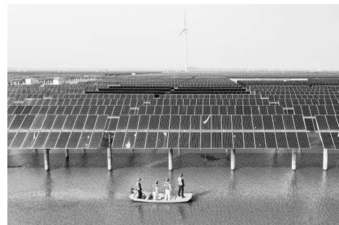
电力工人对江苏省扬州市宝应县射阳湖镇15万千瓦安“风光渔”互补产业发电项目进行巡检。 新华社记者 李博摄
