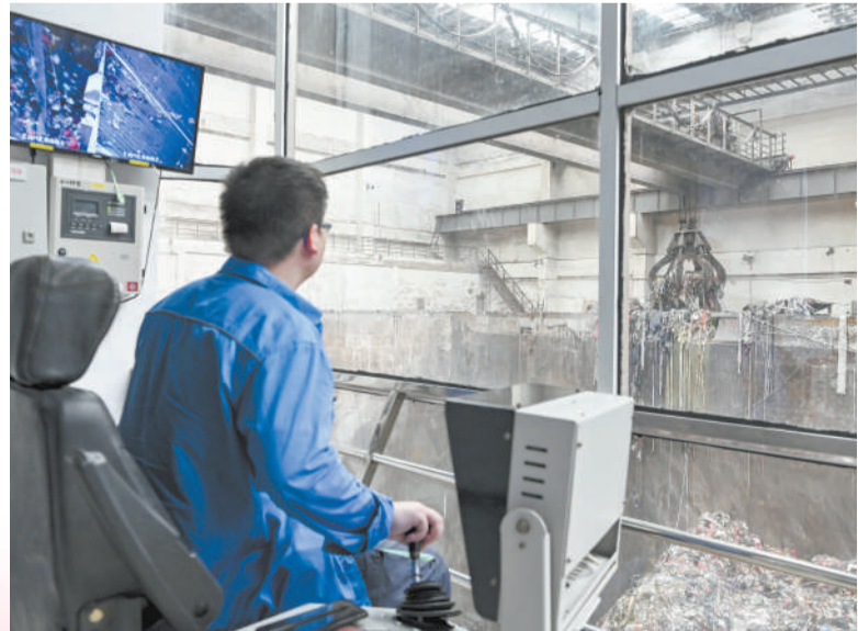
广东省惠州市惠阳环境园内,工作人员操作抓斗将垃圾投入环保焚烧炉,助力绿色循环。视觉中国供图
