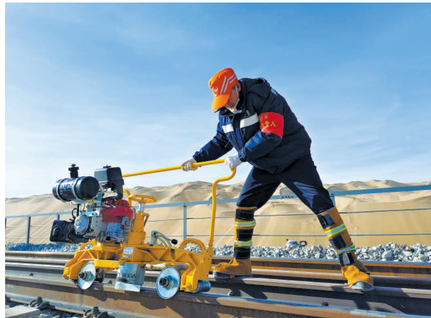
图为铁路职工在沙山沟特大桥上对钢轨工作边结构不平顺点进行打磨。 顾满斌摄
