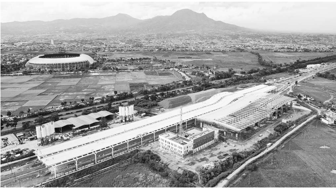
图为2022年10月27日在印度尼西亚万隆拍摄的建设中的雅万高铁卡杜拉车站(无人机照片)。新华社记者 徐钦摄
