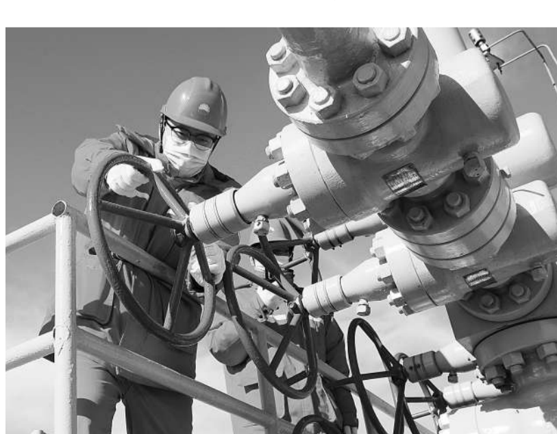
大港油田地下储气库群今冬92口井开发力保障京津冀用气。图为在大港油田旗下板南储气库，操作员工在白6-1井进行开井采气作业（11月13日摄）。新华社发（中国石油大港油田供图）
