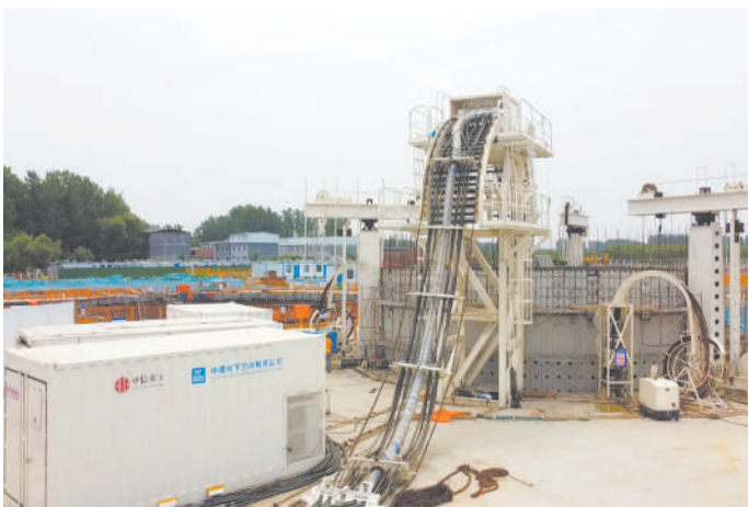
中信重工自主研发的城市地下空间用竖井掘进机 受访者供图
