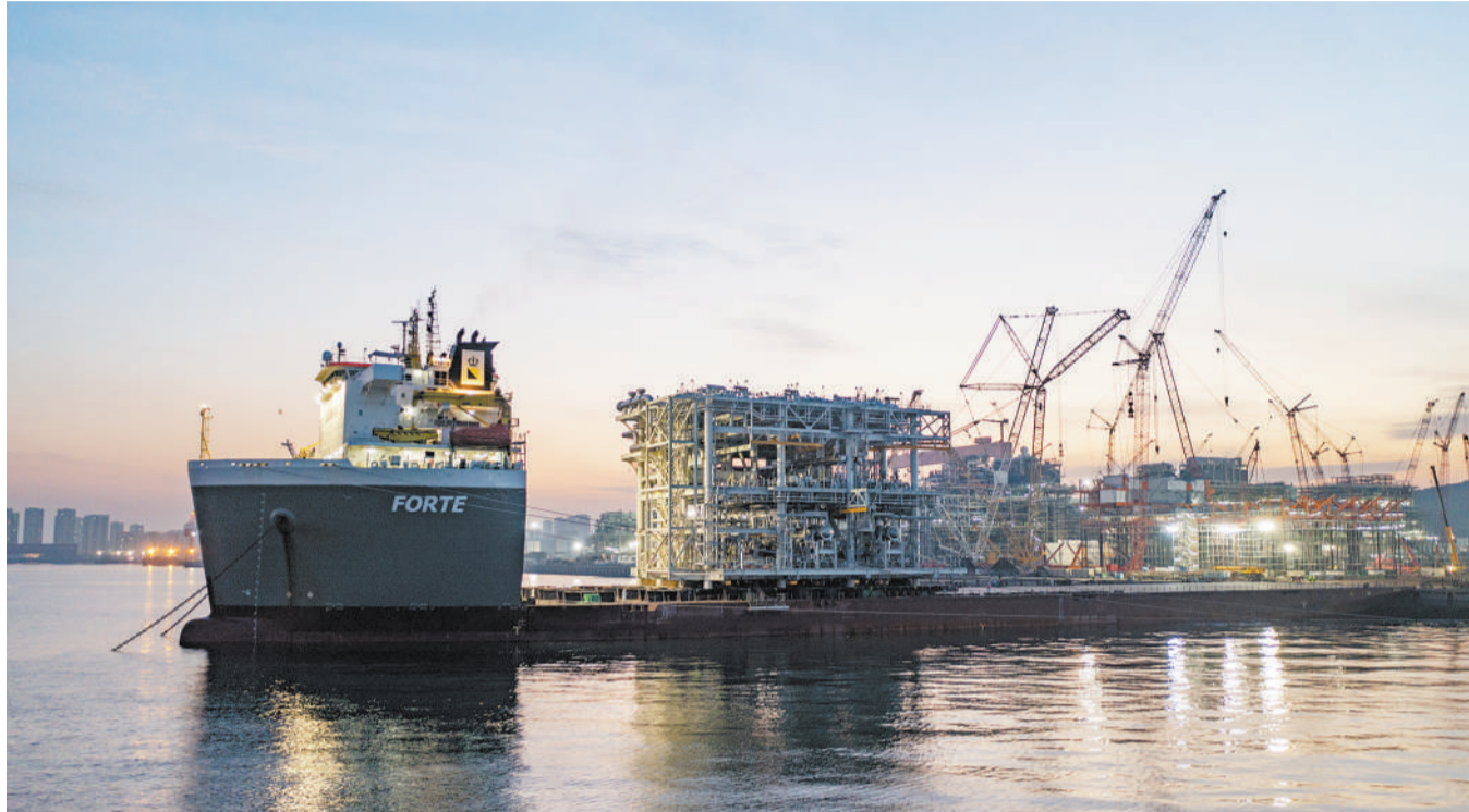
全球首座一体化建造LNG工厂首个核心工艺模块在青岛西海岸新区启航 侯文鹏摄
