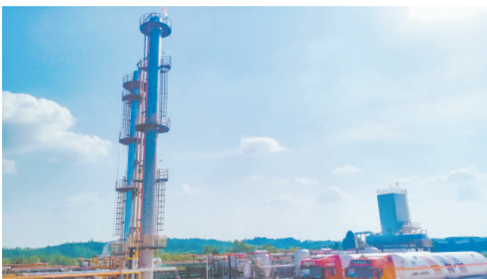
合肥万豪能源设备有限公司建设的国内最大规模井口气净化液化及回收利用项目 合肥高新区供图
