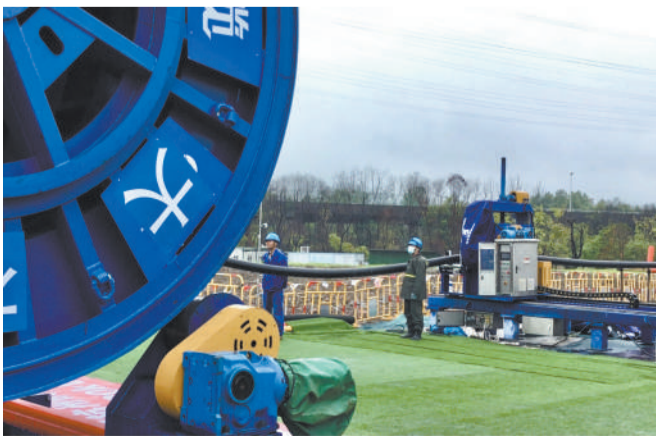
长1715米的220千伏陆地电缆从特制电缆盘上被输送至地下 洪恒飞摄
