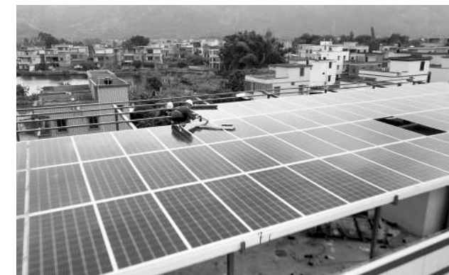
工作人员在新马村村民家中加装屋顶光伏板
