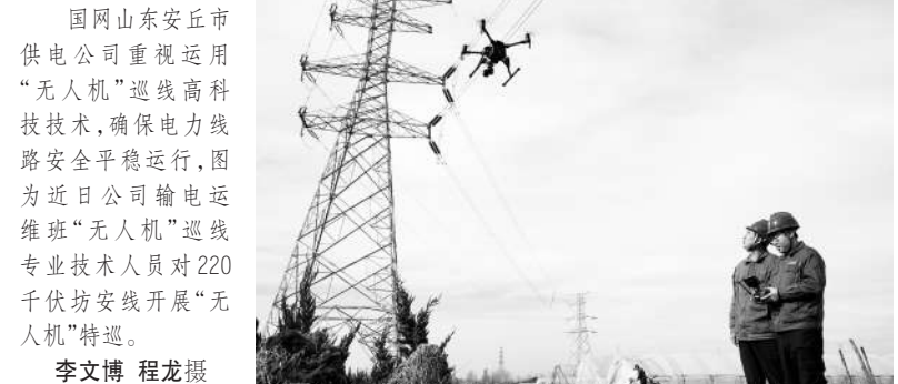
国网山东安丘市供电公司重视运用“无人机”巡检高科技技术，确保电力线路安全平稳运行，图为近日公司输电运维班“无人机”巡检专业技术人员对220千伏坊安线开展“无人机”特巡。
