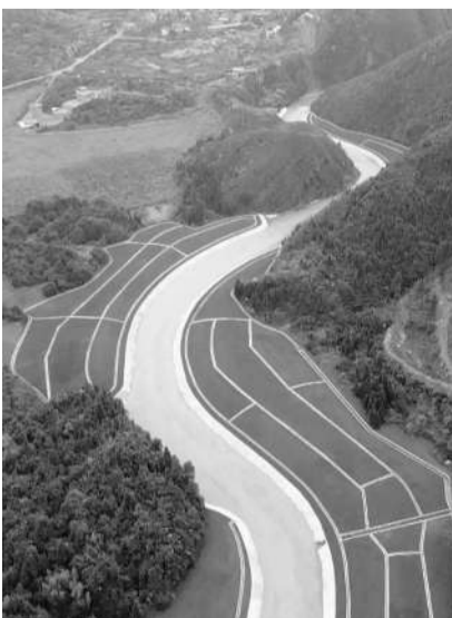
实施重金属污染综合治理工程(三标段)后的陶家河(甘溪河)
