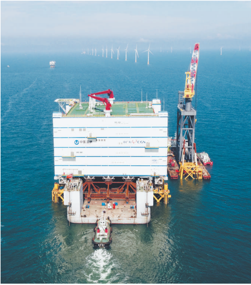
三峡如东海上换流站进点导管架安装完毕
