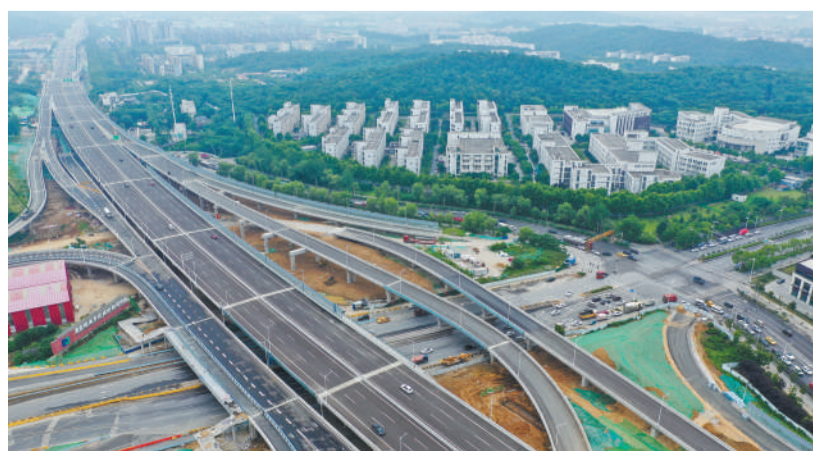
6月30日,由中建安集团等承建的312国道南京段改扩建工程主线高架桥正式通车。该项目为江苏省首个装配式公路桥梁工程,江苏省重大交通工程和重点民生工程,采用装配式建造技术,在原有道路上方架设一条近5公里的“空中快速路”,是完善城市区域路网,促进宁镇一体化的“快速走廊”,给群众出行带来便利。新华社记者 季春鹏摄
