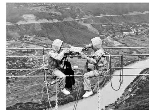
南方电网公司工作人员在安装非电气量集成传感器。
