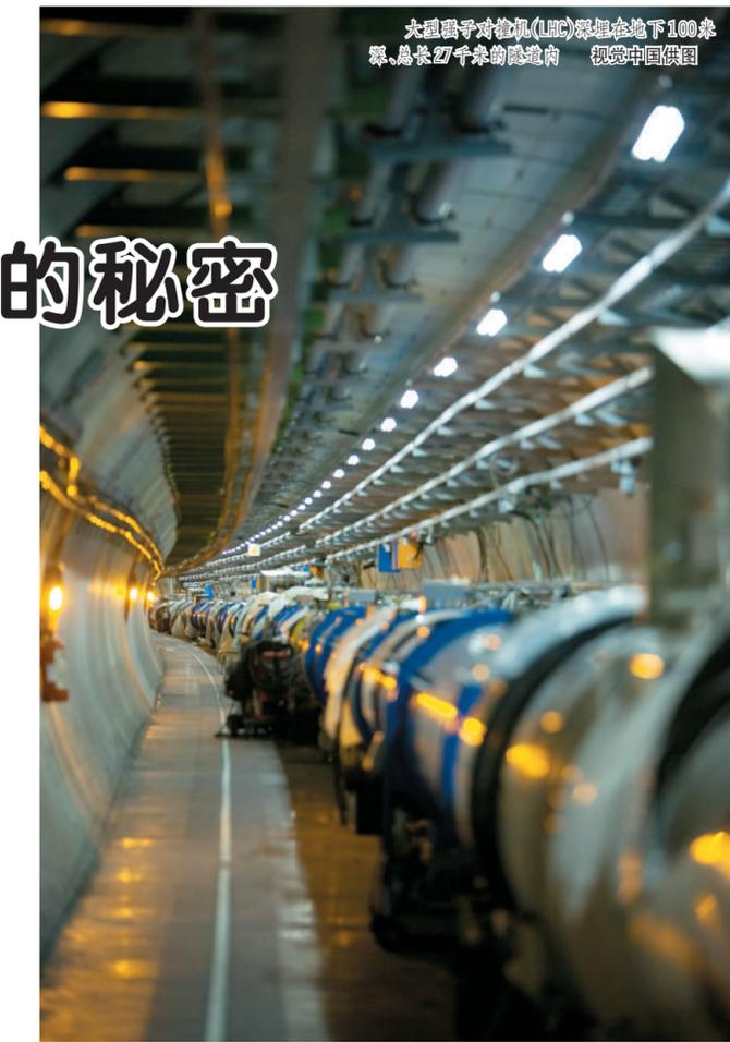
大型强子对撞机(LHC)深埋于地下100米深、总长27千米的隧道内 视觉中国供图
