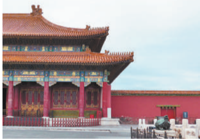
太和殿东侧的防火卡墙 周乾摄
