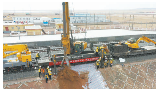
在青藏铁路格拉段沱沱河站进行的电气化接触网基础桩现场试验 受访单位供图
