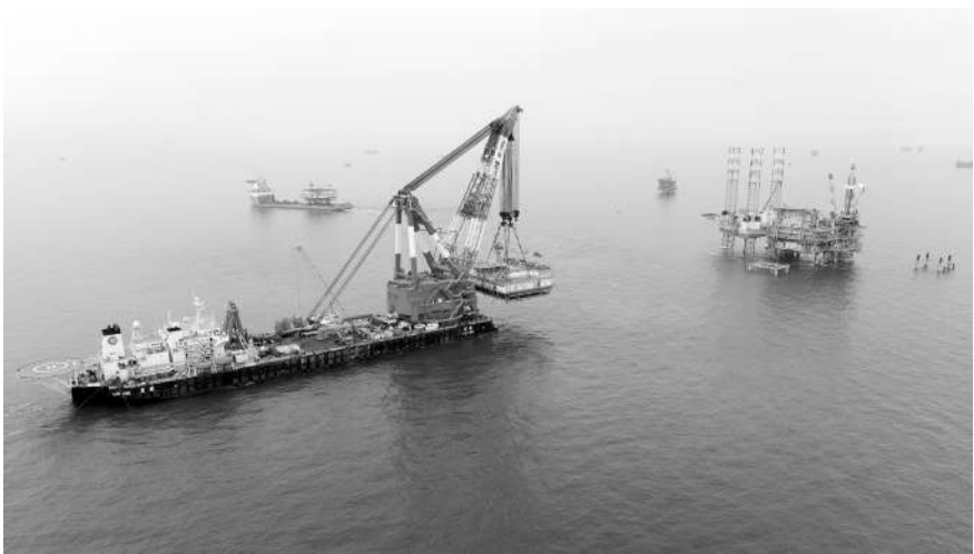
中国海油秦皇岛32-6电力动力平台组块安装
