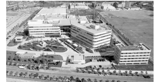
百济神州广州生物药生产基地第二工厂在广州知识城竣工,第三工厂建设同步启动。 李剑锋摄
