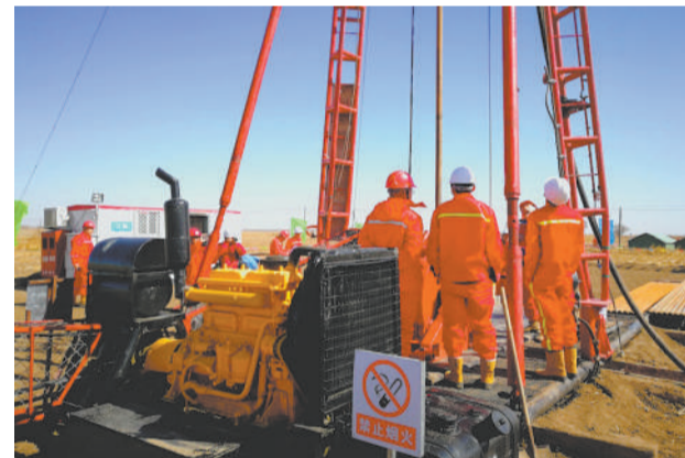
辽河油田科研人员在铀矿开钻验收现场检查设备安装情况 受访者单位供图
