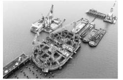
3月16日,世界在建最大水 中沉井基础江苏常泰长江大桥5 号墩钢沉井封底混凝土浇筑完 成。沉井搭载了中交二航局首次 研发的沉井施工全过程智能监控 系统,内部安装有200余个监控 元器件,可自动采集、实时监测相 关数据,实现施工全过程可测、可 视、可控。图为完成后的5号墩 本报记者 矫阳摄
