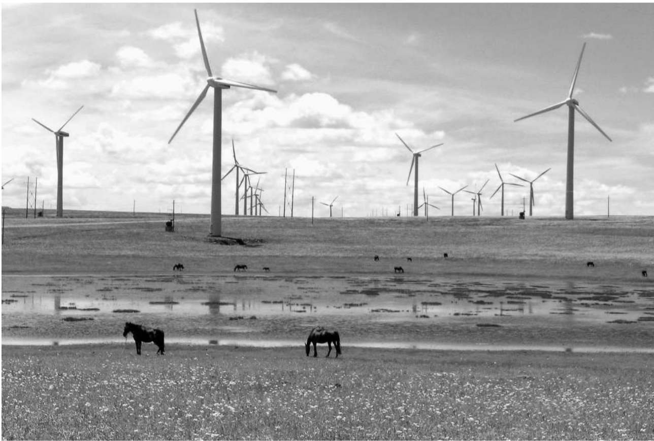
风电消纳技术示范风场
