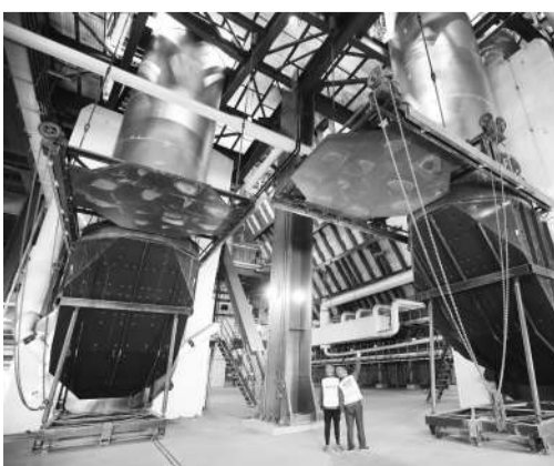
国内最大型号风扇磨煤机安装现场
