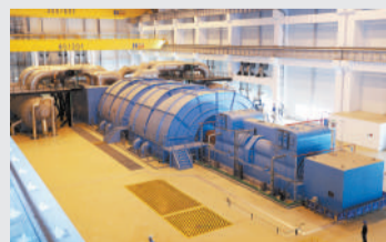
华龙一号全球首堆福清核电5号常规岛厂房
