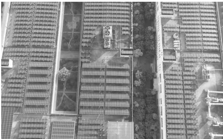
广州开发区分布式光伏发电备案总装机容量超140兆瓦。图为阿蓝尔股份有限公司屋顶分布式光伏发电项目。 受访者供图
