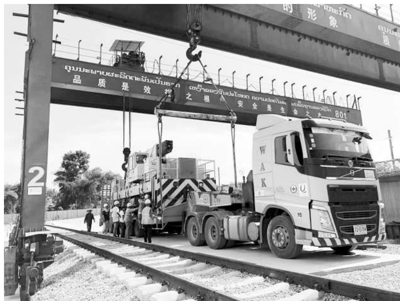
11月19日，中老铁路国内段研和至岷山区间电气化接触网导线开始架设，国外段万象北至万象区间接触网同步架设，标志着中老铁路全线“四电”工程进入施工关键阶段。中铁武汉电气化局玉磨项目部总工程师赖鹏介绍，本次施工采用智能工及信息化管理系统，确保作业安全和工程进度。图为中老铁路电气化施工装备分批分期运抵老挝。贺玉琴 昌檀 本报记者 陈瑜文 刘明摄
