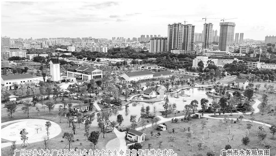
广州石井净水厂采用地埋式生态化全生命周期管理模式建设。
