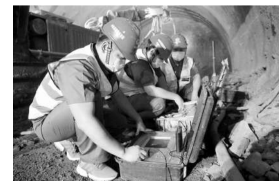
施工现场使用HSP技术 受访者供图
