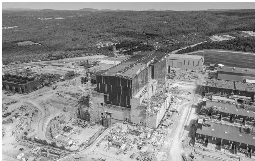
位于法国南部卡达拉舍的ITER施工现场鸟瞰图。图片来源:ITER国际组织网站
