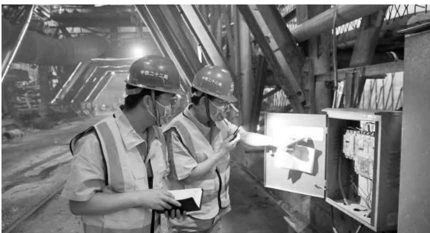
图为中铁二十二局技术人员在查验隧道衬砌质量检测信息线路。
