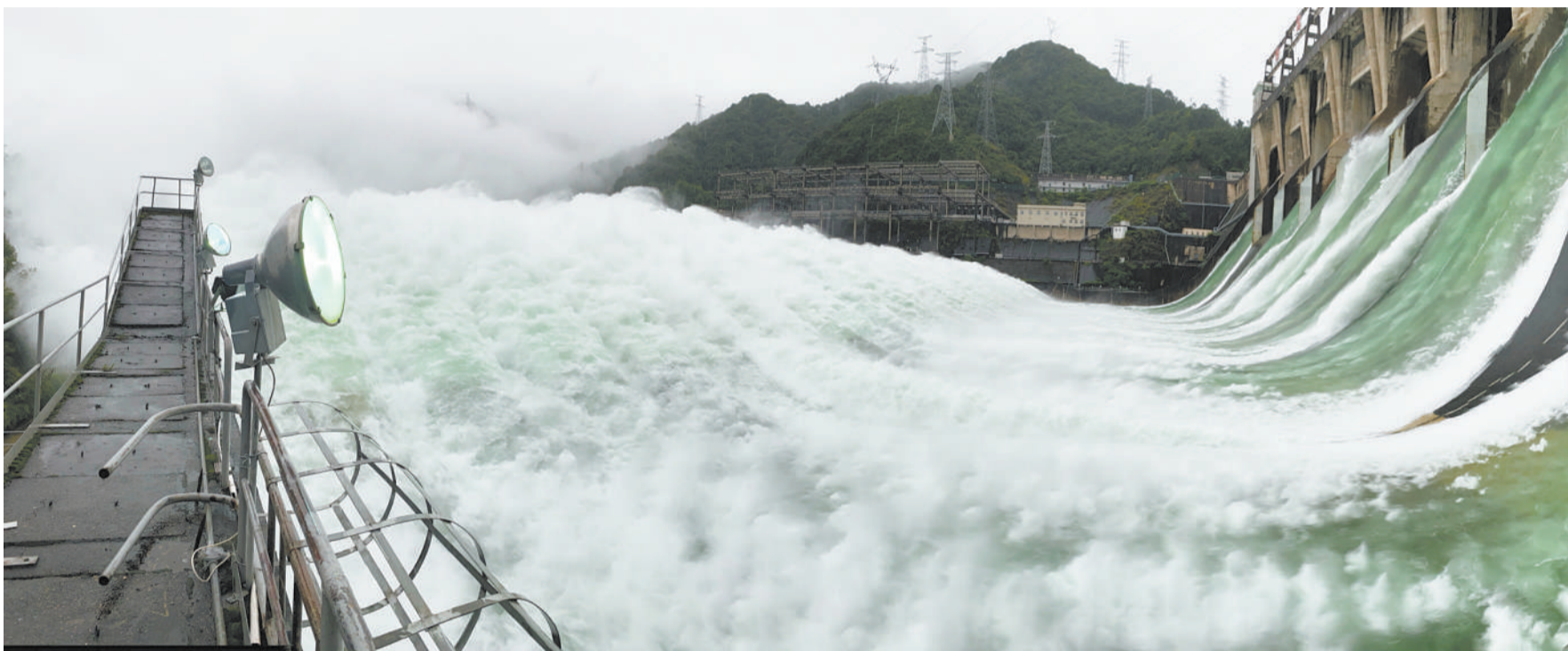
受持续降水影响,浙江新安江水库水位持续快速上升。继当日10时开启3孔、12时开启5孔泄洪后,新安江水库于16时增加到7孔泄洪。新安江水库是华东地区最大的水库,在钱塘江流域的防洪度汛中起到关键作用。图为7月7日下午开启7孔泄洪的新安江水库(手机全景模式拍摄)。
