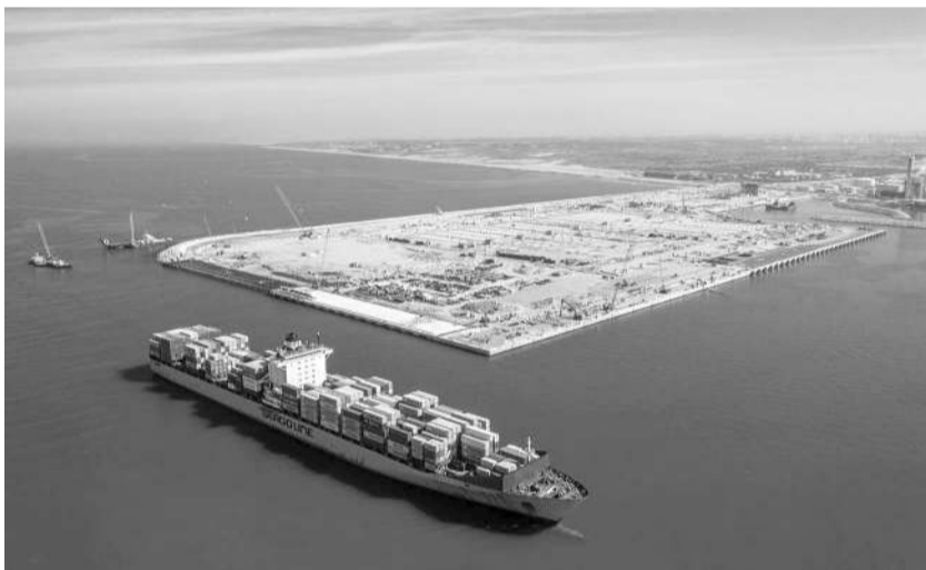
正在建设的阿什杜德新港。
