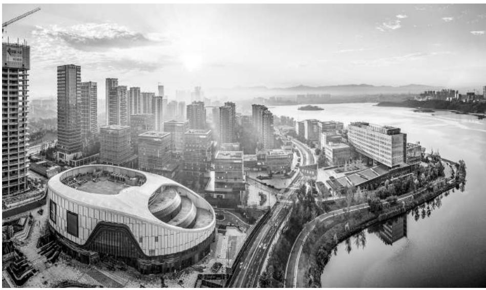
建设中的天府新区成都直管区 天府新区融媒体中心供图
