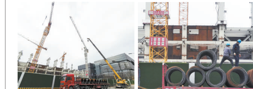
近日,北京市国家会议中心二期、北京冬奥村、机场线西延等一批重点建设工程已陆续恢复施工。工程各参建单位采取医学观察区、生产区分类管理等科学防控方式进行施工,严格每日登记、测温、消毒等制度,分组、分区域轮流施工,力争高质量按时完成施工任务。
