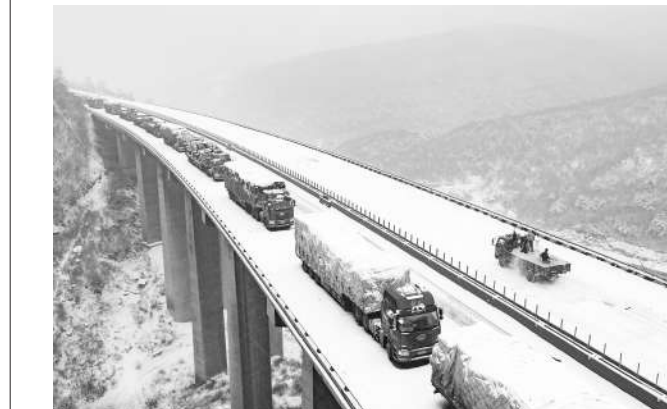
1月7日山西交控集团吕梁南高速分公司的公路养护人员在青银高速吕梁段布撒融雪剂(无人飞机照片)。
