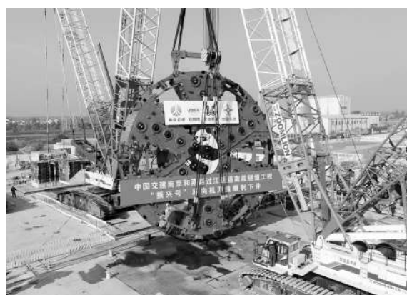
12月25日上午,我国自主制造的“振兴号”超大直径盾构机在南京和燕路穿越长江隧道右线工程成功始发,这是国内自主研发的超大直径常压刀盘盾构首次穿越长江江底。 本报记者 矫阳摄
