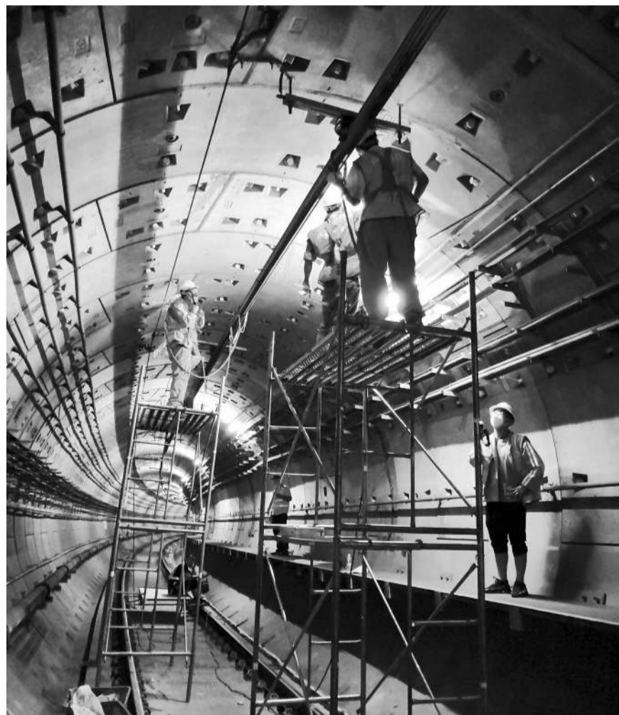
地铁工程管片裂损修复
