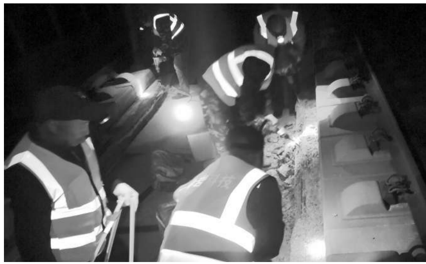
高铁工程底座板板修复
