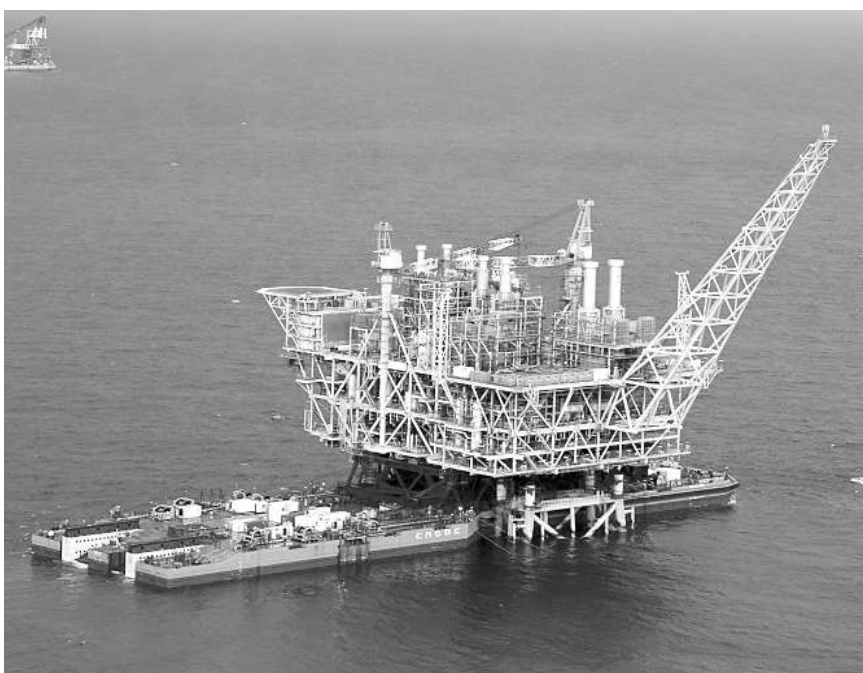
海洋石油工程股份有限公司“荔湾3-1”气田项目海上俯瞰图
