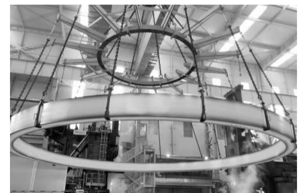
世界最大无焊缝整体不锈钢环形锻件吊装
