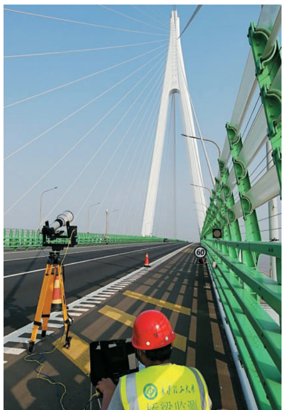
2018年度技术发明一等奖——长沙理工大学“大跨度混凝土桥梁服役安全保障若干新技术”,发明的桥梁外观病害远程智能检测系统在杭州湾大桥进行精准检测。
