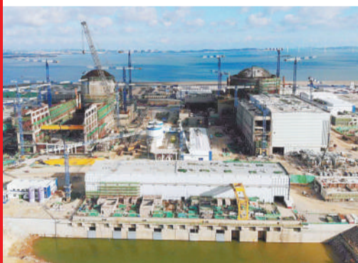
建设中的“华龙一号”机组福清核电现场。
