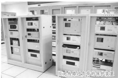
新视角，放弃了常用的阻抗平面，巧妙地在电压平面上提取出线路过负荷与不同类型线路故障的辨识参数，实现了线路过负荷与故障的精准识别，解决了线路过负荷引发连锁故障这一世界性技术难题。
