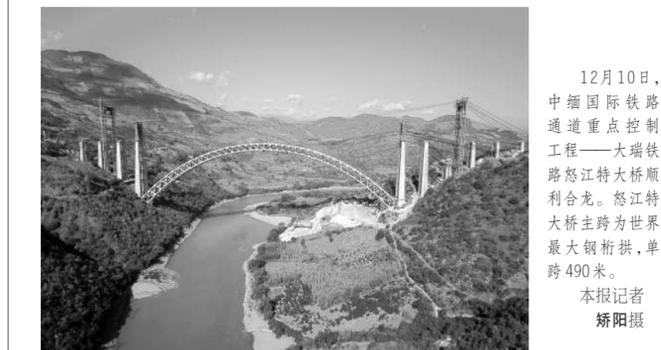
12月10日,中缅国际铁路通道重点控制工程——大瑞铁路怒江特大桥顺利合龙。怒江特大桥主跨为世界最大钢桁拱,单跨490米。本报记者 杨阳摄
